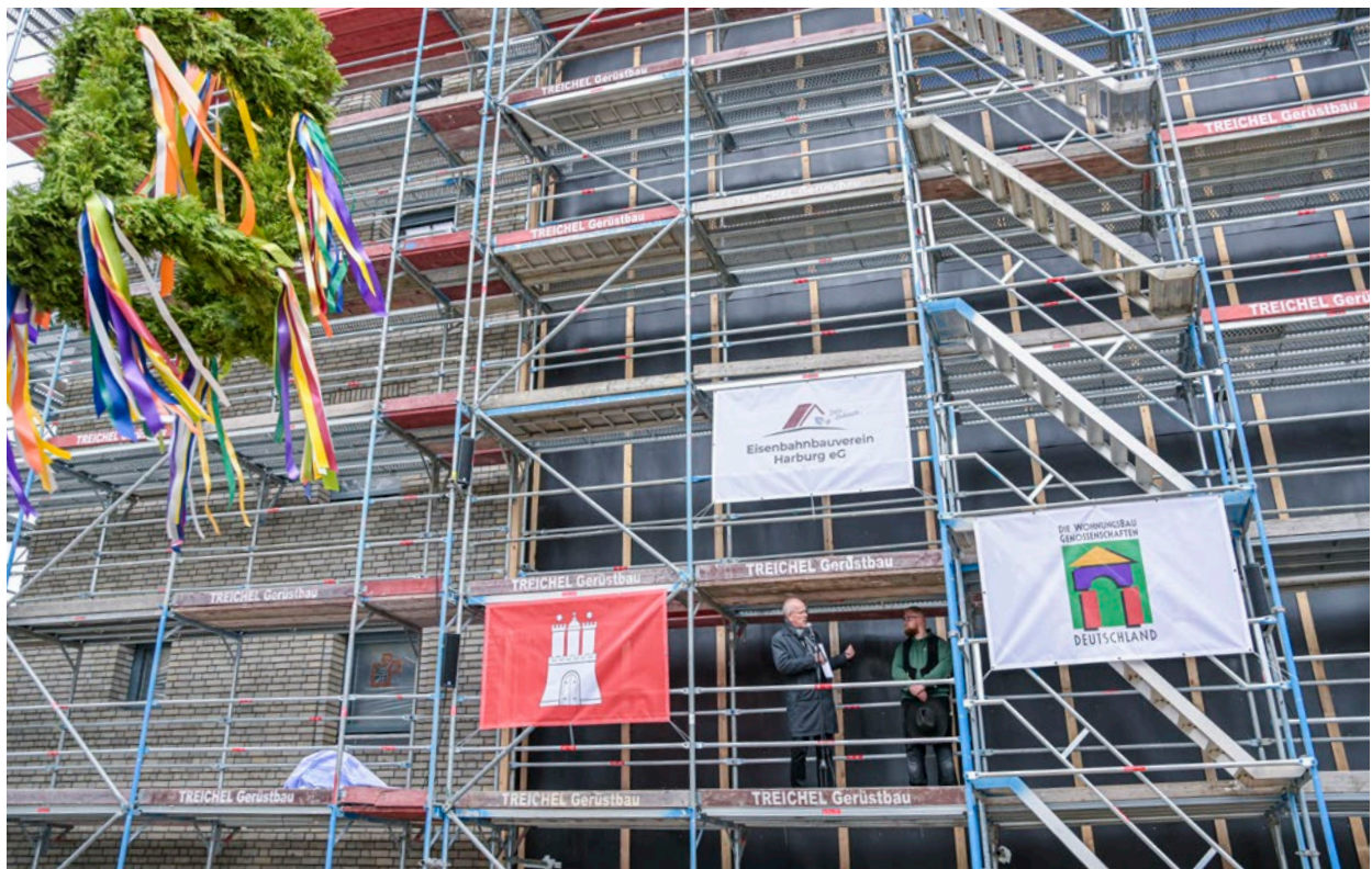
Richtfest Bremer Straße
