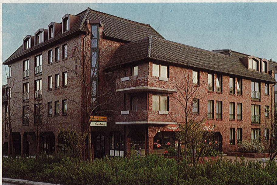
Als Beispiele für moderne Bauvorhaben mit hoher Wohnqualität gelten die beiden Wohnanlagen unserer Genossenschaft am Schwarzenberg.
