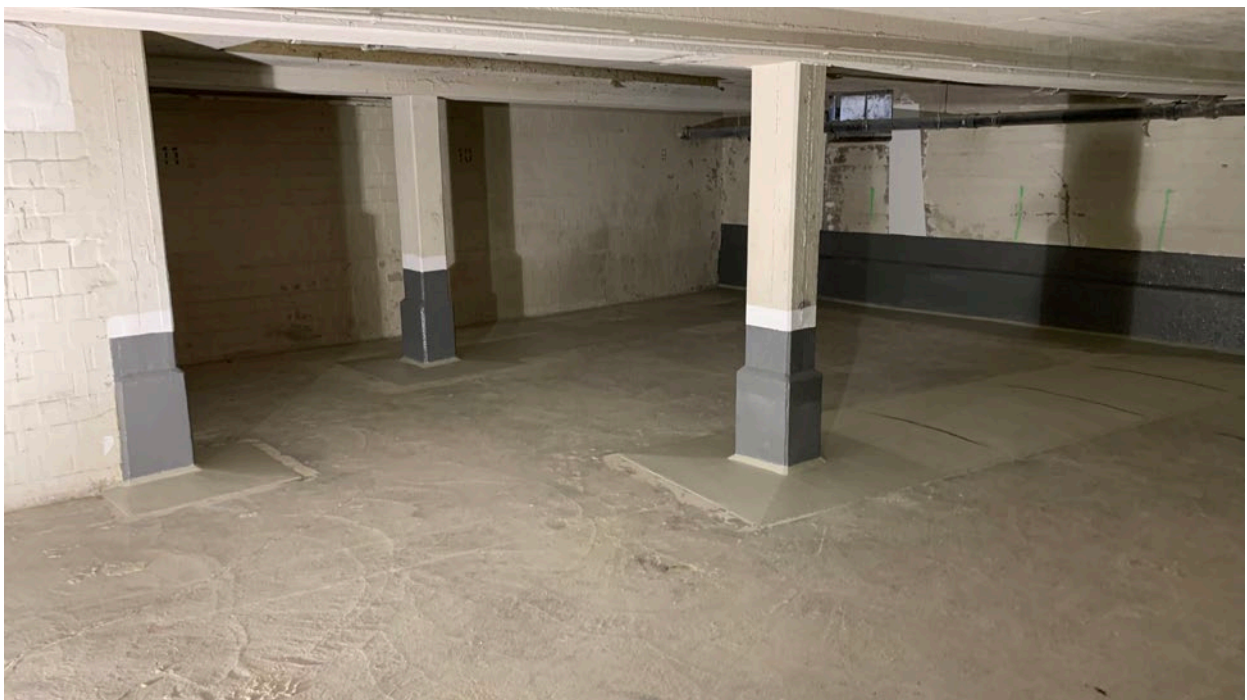
Tiefgarage Schwarzenbergstraße 58 – Betonsanierung abgeschlossen
