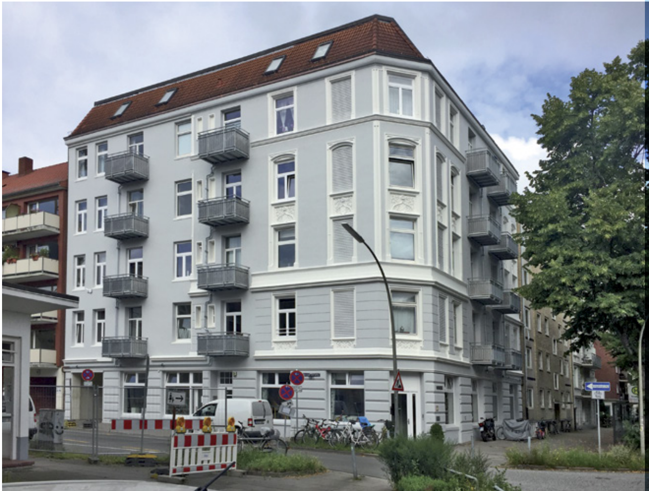
Mozartstraße 35 - Fassadensanierung und Balkonerneuerung
