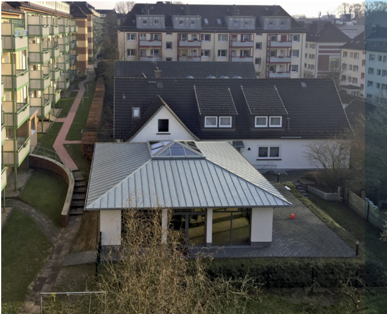
Erweiterung der Geschäftsstelle Rosentrepp 1 a
