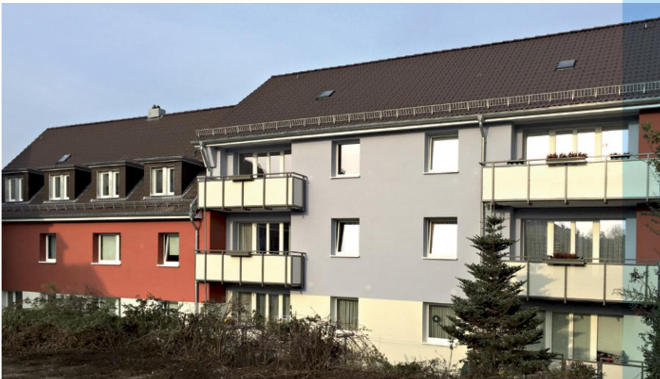
Kniggestraße 7 + 9 Hofansicht – alte 6 cm Dämmung entfernt – neues Wärmedämmverbundsystem mit 16 cm angebracht.
