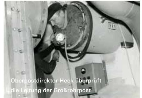
Oberpostdirektor Heck überprüft die Leitung der Großrohrpost
